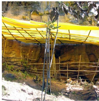
Figura 06: Cobertura provisória para contenção de água da chuva e insolação no abrigo.
